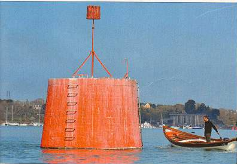
La tourelle des Zébres, à proximité du barrage, marque le début du balisage de bâbord en Rance.
