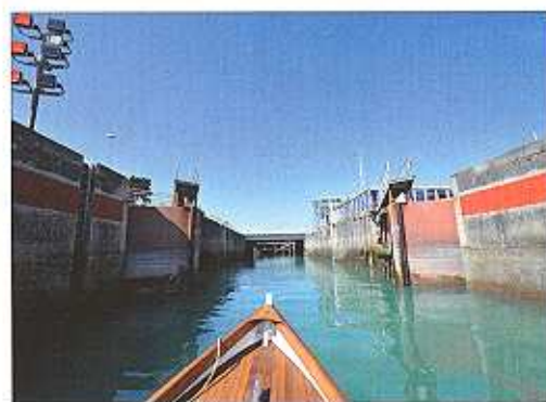
Autre moyen pour accéder en Rance : via l'écluse du barrage qui ouvre à heure ronde tous les jours, sauf en cas de gros coefficient.
